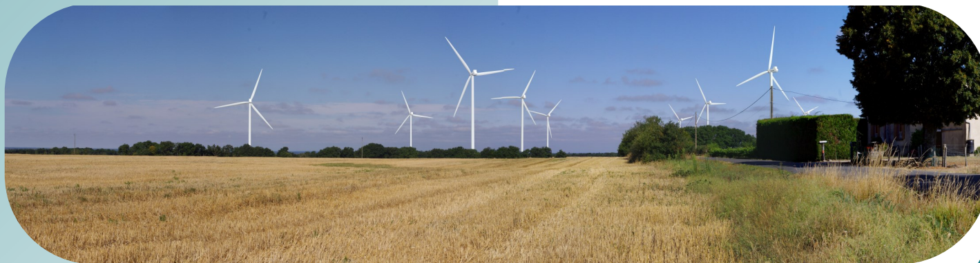
10 éoliennes — Vestas V126 (126 m de diamètre de rotor) — 180 m en bout de pale — 3,45 MW de puissance unitaire
